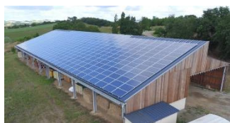
Hangar photovoltaïque à Samatan © EDF ENR – JMV
